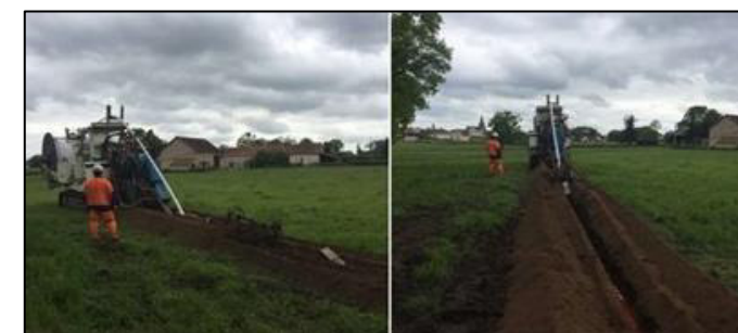
Figure 234 : Exemples de chantier d'enfouissement d'un réseau électrique en terres agricoles (Sources : URBA 399, Cegelec info)
